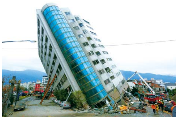
2018年2月7日に台湾東部で発生した地震で倒壊
